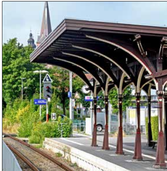
Das Vordach des Plöner Bahnhofs stammt vom Bahnhof Holsteinische Schweiz in Krummsee.
