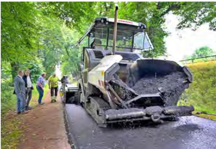
**Das heiße Mischgut wird regelmäßig durch Themo-Lkw angeliefert und mit dem Baufahrzeug verteilt – dabei wird die Straße ein bisschen höher und breiter, so dass in der anschließenden Nachbereitung die Bankettstreifen aufgefüllt werden müssen.**
