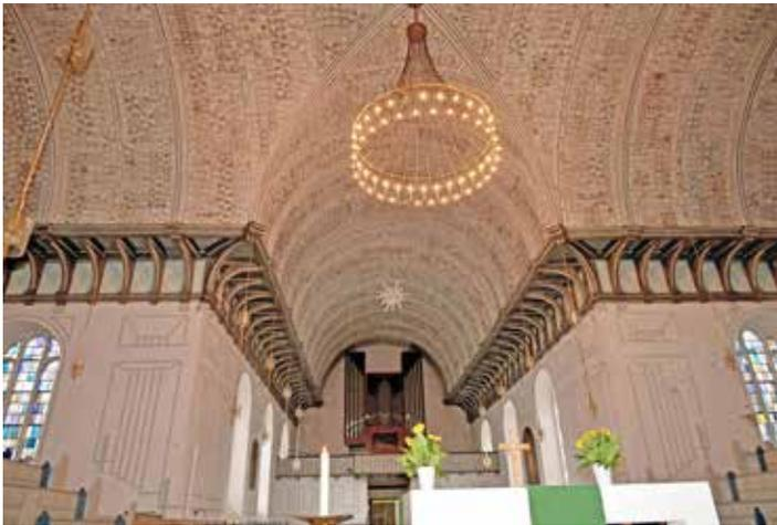
**Der Dachstuhl mit dem Tonnengewölbe lastet auf den Außenmauern der Kirche.**
