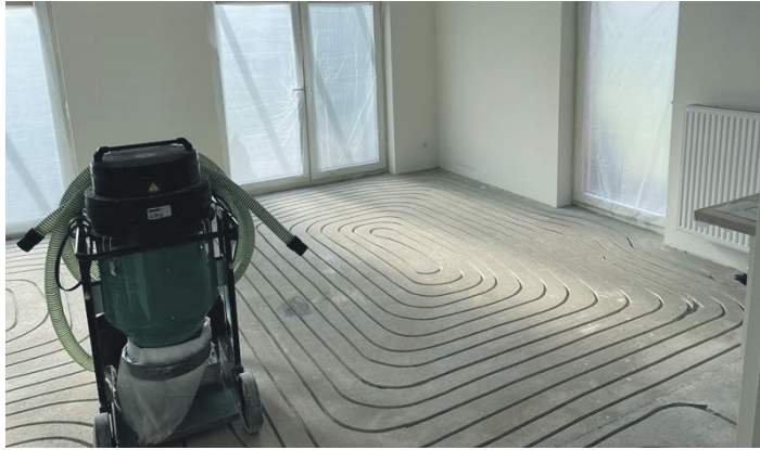
Die Estrichfräse kann individuell für eine optimale Wärmeverteilung eingestellt werden.
