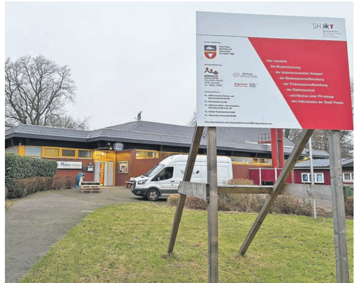
Noch werden die letzten Arbeiten in der Schwimmhalle in der Johannes-Gutenberg-Straße erledigt. Foto: Graap
