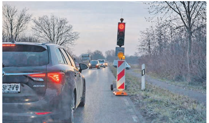
Schon jetzt behindern Bauampeln den Verkehr auf der B 76 vor Plön. Die Vorbereitungen für die Baumaßnahme laufen. Fotos: Graap
