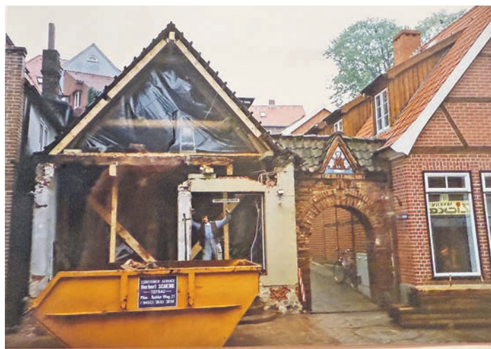
Umbau Lange Straße 47: In sechs Monaten entstand hier die „neue“ Eisenpfanne.
