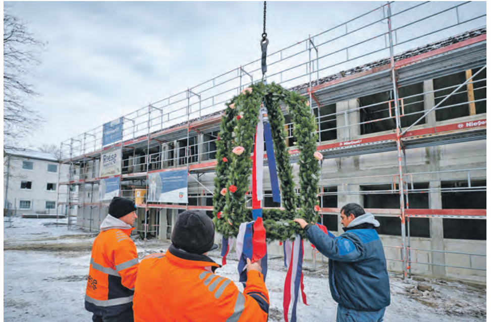
Kein Richtfest ohne Krone: Der Kranz, den die Mitarbeiter der Baufirma Reese hier am Kran befestigten, wurde von der Gärtnerei Möller gebunden. Fotos: Graap
