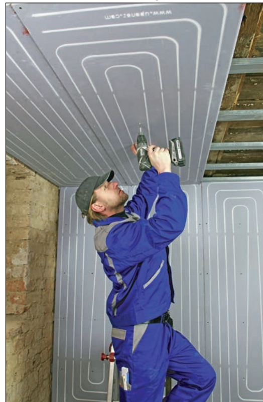
Schneller Austausch des Heizsystems: Spezielle Trockenbausysteme für Wand und Decke vereinfachen die Modernisierung.
