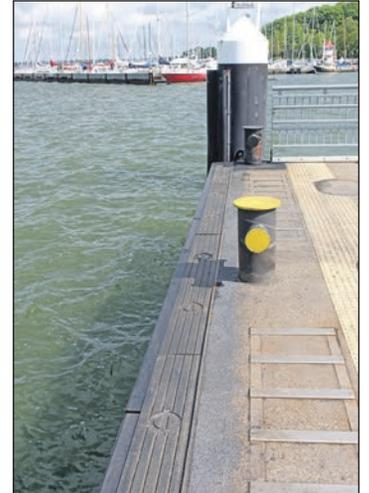
Der reparierte Brückenkopf mit dem durchgehenden neuen Fender.
