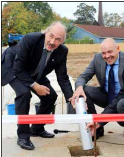
Bürgermeister Alexander Orth und Dr. Robin Heidel, Firma Goldbeck versenken die „Zeitkapsel“ im Fundament. Fotos: Asmus
