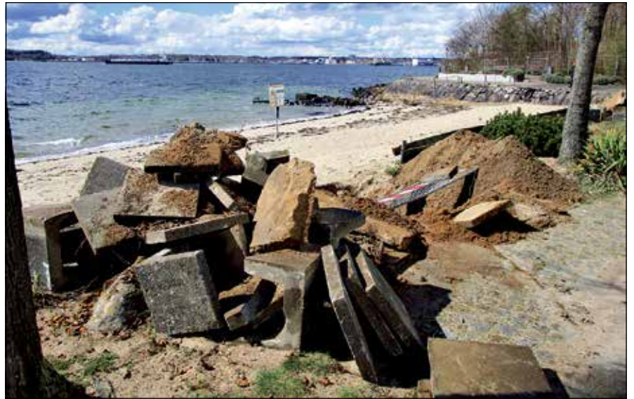
Die alten Einfriedungen und der Plattenbelag unter den Ruhebänken werden entfernt – in den kommenden Monaten soll hier die bereits erfolgte Neugestaltung des Uferwegs fortgesetzt.
