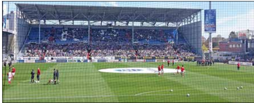
Wird aufgestockt: Das Holstein Stadion am Mühlenweg.
