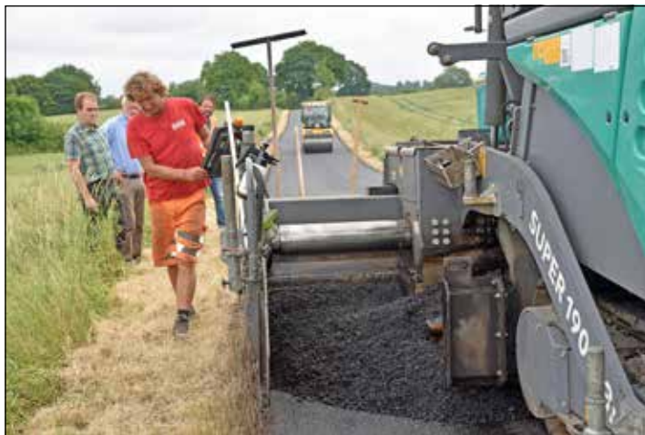
Fließende Übergänge: gut isolierte Lkw liefern im Wechsel heißen Teer für die Straße Darland in der Gemeinde Mucheln an, auf der eine neue Decke aufgetragen wird.
