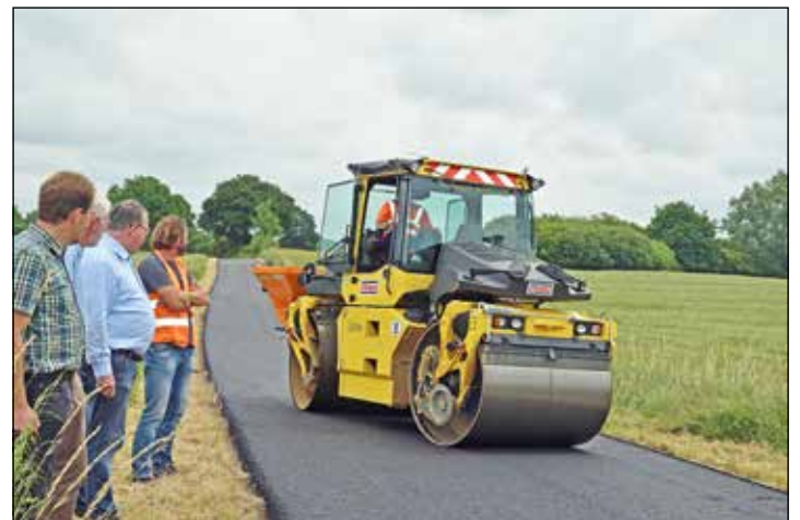
Während die frische Teerschicht auf die Straße fließt, arbeitet die Walze bereits im Schlepptau des Kippers.
