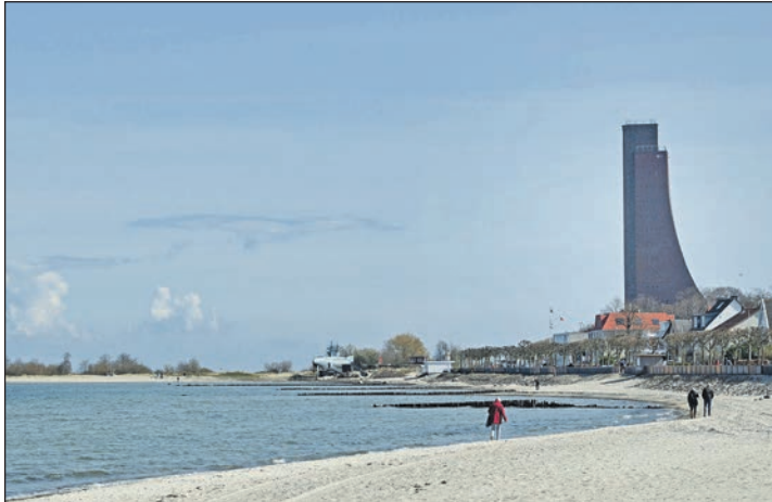
Am Marine-Ehrenmal in Laboe nagt der Zahn der Zeit. Der Deutsche Marinebund wirbt um Spenden, damit das Bauwerk vor dem Verfall gerettet werden kann. Foto: Schneider
