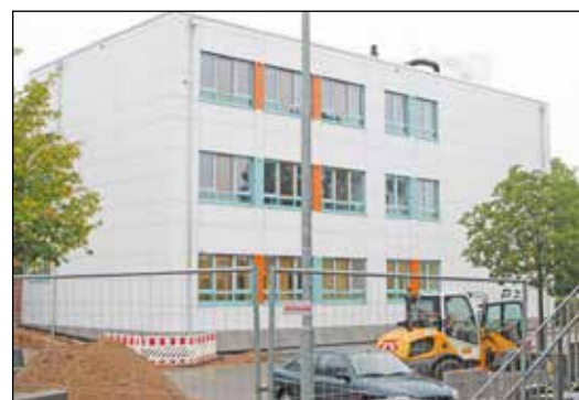
Das Gebäude ist fertig, nur noch einige Restarbeiten im Außenbereich sind zu erledigen
