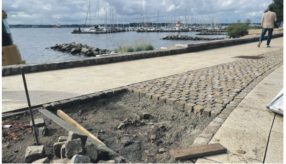
Fast fertig, aber eben nur fast: Die neue Promenade in Mönkeberg wirkt einladend. Doch mittendrin klaffen noch einige Baustellen. Fotos: Münch
