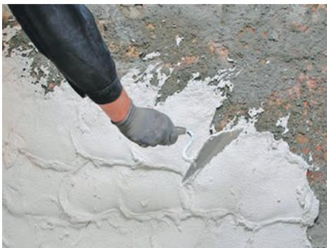
**Spezielle Sanierputze ermöglichen das effektive und schnelle Ausbessern von Feuchtigkeitsschäden.**
