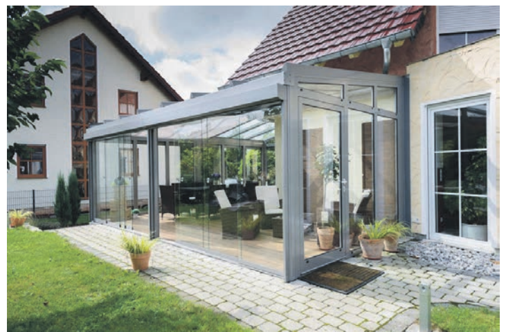
Ein „Glashaus“ beziehungsweise ein „Sommergarten“ erlauben eine erhebliche Verlängerung der Freiluftsaison, auch wenn das Objekt nicht wie ein vollwertiger Wohnraum genutzt werden kann.
