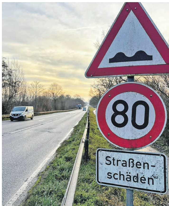
Vor Plön soll die Bundesstraße 76 auf gut zwei Kilometern im ersten Bauabschnitt zunächst 23 Monate lang gesperrt werden.
