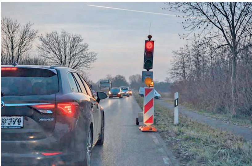
Schon jetzt behindern Bauampeln den Verkehr auf der B 76 vor Plön. Die Vorbereitungen für die Baumaßnahme laufen.
