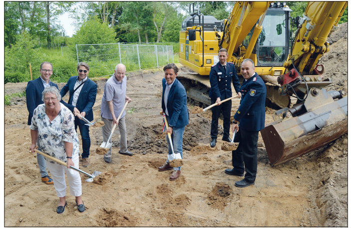
Nahmen gemeinsam den ersten Spatenstich vor: die Architekten Torben Suhr (v.l.) und Wolfgang Bruch, Ratekaus Bürgervorsteherin Gaby Spiller, Dorfvorsteher Christian Krogmann, Bürgermeister Thomas Keller, Gemeindeführer Christian Ziemann und Ortswehrführer Fabian Fuhrmann.
