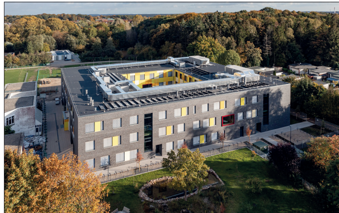
Nach nur 15-monatiger Bauzeit wird jetzt das neue Gymnasium am Mühlenberg eingeweiht. Foto: Tim Voelter
