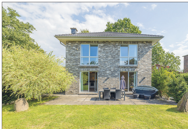
Die traumhaft schöne Stadtvilla liegt in idyllischer Lage in der Gemeinde Ratekau. Foto: hfr
