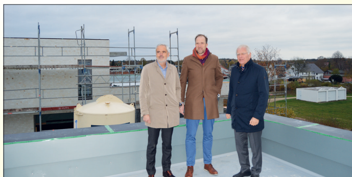
Nahmen die Baustelle im Neubaugebiet Pansdorf in Augenschein und tauschten sich in Sachen sozialer Wohnungsbau aus: VNW-Direktor Andreas Breitner (li.), Wobau-Geschäftsführer Fabian Weist (m.) und Wobau-Aufsichtsrat Landrat Reinhard Sager.
