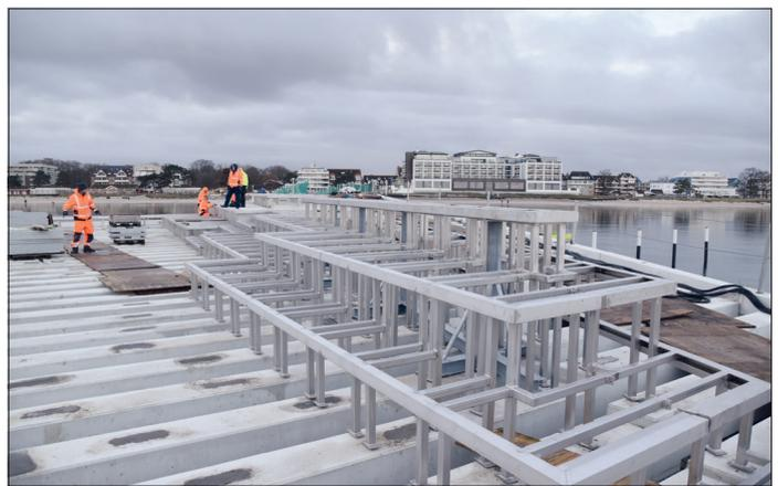
Auf dem Seebrückenkopf montieren Bauarbeiter die große Stahlunterkonstruktion, auf denen später Sitzmöglichkeiten zum Verweilen zu finden sein werden.
