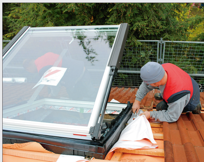
Energetische Optimierung im Dachbereich: Die Modernisierung von Dachfenstern ist ein nützlicher Beitrag zur Wärmedämmung. Werkfoto: Bayerisches Dachdeckerhandwerk
