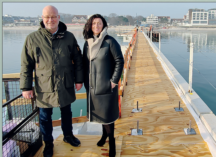
März 2024: Dipl.-Ingenieur Andreas Geist vom Bauamt der Gemeinde Scharbeutz und Bürgermeisterin Bettina Schäfer auf der im Bau befindlichen Scharbeutzer Seebrücke.
