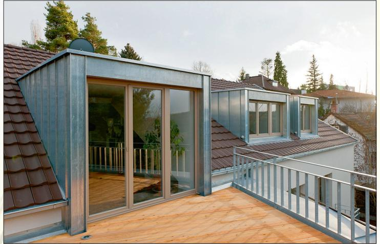
Der Einbau von Dachgauben bringt Licht ins Dachgeschoss und schafft zusätzliche Raumhöhe. Werkfoto: IVPU
