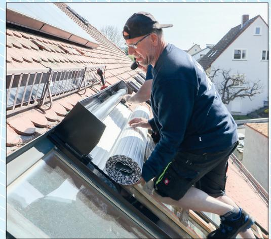
Befestigung des Rolllädenbehangs am Rolllädenkasten.
