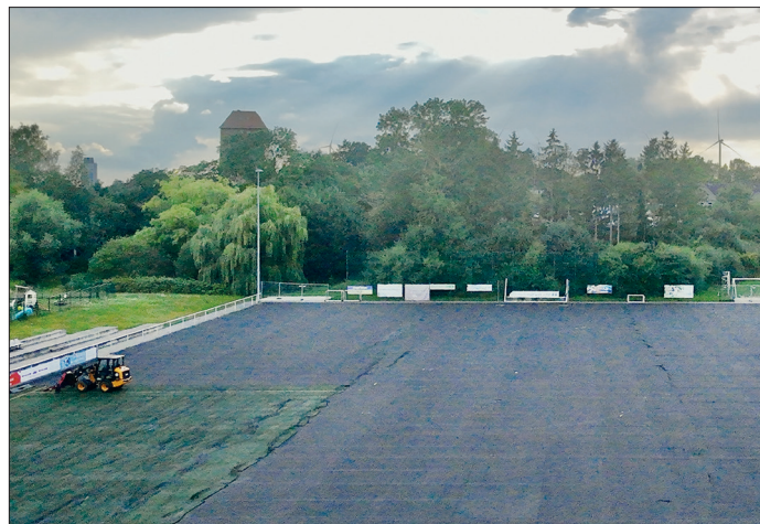
Auf rund 6.100 Quadratmetern wird derzeit der Kunstrasenplatz der SVG Pönitz erneuert. (Fotos: hfr)
