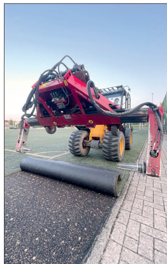
Der neue Kunstrasen wird fachmännisch auf dem Sportplatz in Pönitz verlegt.
