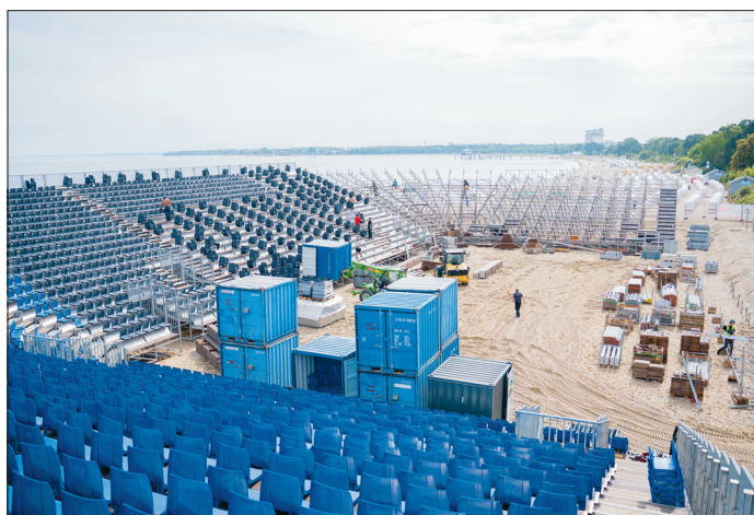
Für den Stadionaufbau mit Tribünen werden insgesamt 280 Tonnen Material verwendet. (Foto: TSNT/Stine Schöning)
