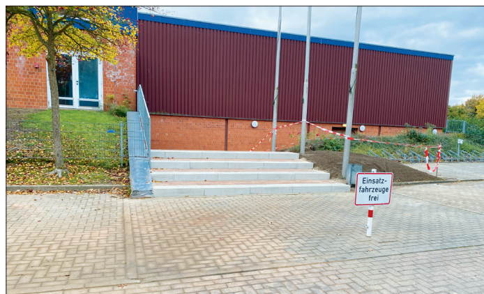
Die neue Treppenanlage soll verhindern, dass Wasser bei Starkregen über den Haupteingang in die tiefergelegene Großsporthalle eindringt.
