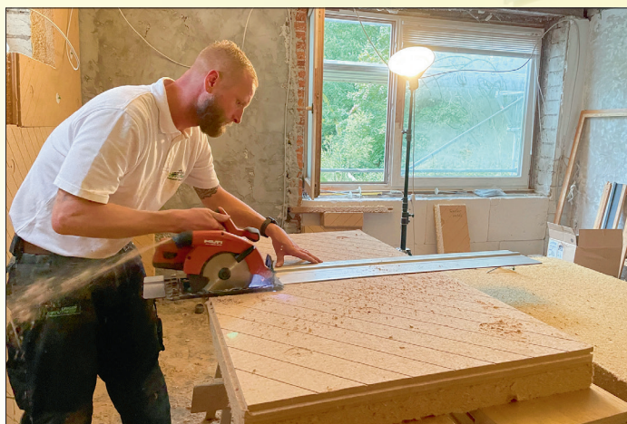
Der Zuschnitt der Dämmplatten erfolgt mit einer Handkreis- oder Stichsäge. Werkfoto: UdiDämmsysteme
