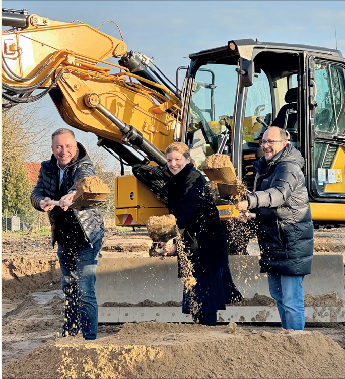
Marco Fibelkorn (li.), Bürgermeisterin Julia Samtleben und Jan-Christian Ohm beim ersten Spatenstich. Foto: Gemeinde Stockelsdorf
