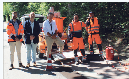
Die Gemeinde Ahresbök hat sich einen Straßenvergussaufbereitungskocher zugelegt, der es ermöglicht, schnell und gezielt marode Straßenabschnitte im Gemeindegebiet in Eigenleistung auszubessern. Hintergrund ist der Fachkräftemangel in den ausführenden Betrieben und die damit verbundenen langen Wartezeiten sowie Einsparungen von Haushaltsmitteln .
