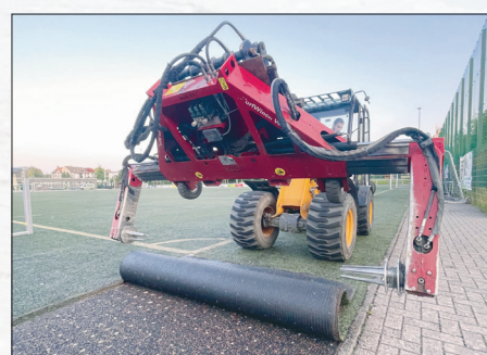
Die SVG Pönitz startet mit Rückenwind in die neue Saison: Der in die Jahre gekommene Kunstrasenplatz aus dem Jahr 2012 wurde auf einer Fläche von rund 6.100 Quadratmetern komplett erneuert und mit Saisonauftakt am 16. August offiziell eingeweiht.
