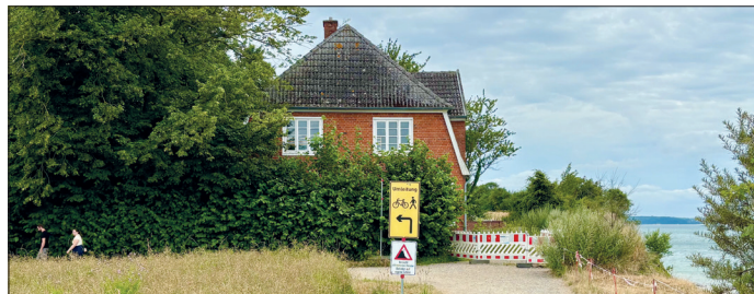
Das Haus Seeblick am Brodter Steilufer wird in diesem Monat im Rahmen einer sogenannten Ersatzvornahme abgerissen. (Foto: Hansestadt Lübeck)
