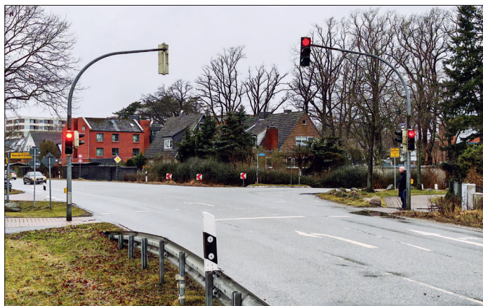
Die Kreuzung B76/Hafenstraße/Vogelpark-Parkplatz in Niendorf/Ostsee bekommt eine Vollverampelung. Dazu starten jetzt die Bauarbeiten.
