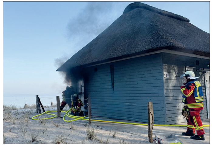
In Scharbeutz kam es zu einem Feuer in einem reetgedeckten Toilettenhaus. (Foto: DS/FFS)
