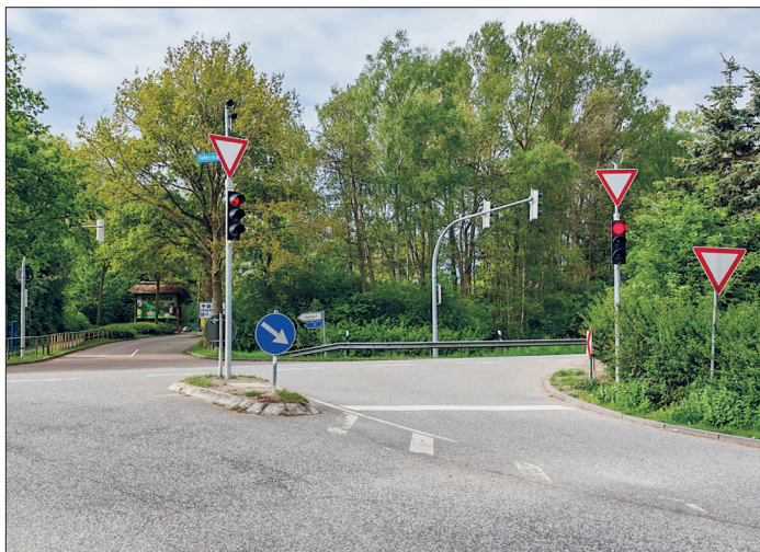
Nachdem die neue Ampelanlage an der Kreuzung B 76/Hafenstraße/Vogelpark-Parkplatz in der vergangenen Woche fertiggestellt wurde, läuft der Verkehr auch wieder über die Hafenstraße zur B 76 und umgekehrt.
