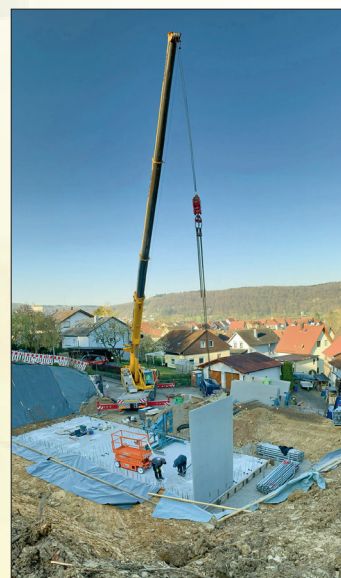
Vor dem Hausbau sollte der Baugrund analysiert werden. Werkfoto: GÜF/Bürkle Kellerbau
