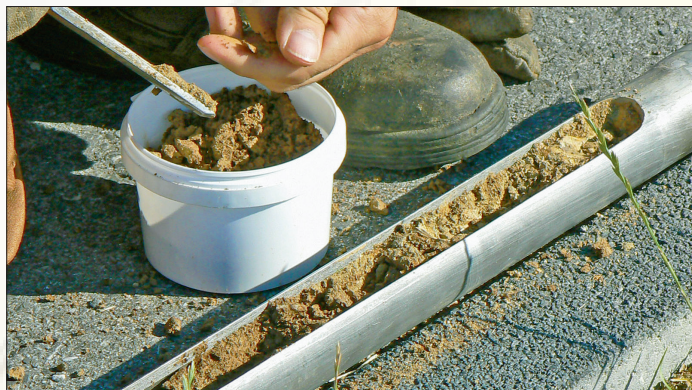
Bohrungen bis tief ins Erdreich hinein sind für ein fundiertes geologisches Baugrundgutachten zwingend erforderlich.
