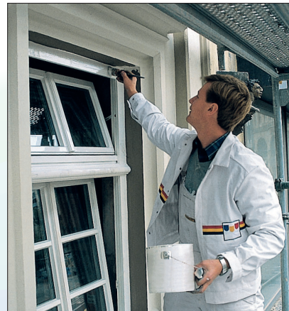
Im Frühjahr und Sommer steht auch die Lackierung von Holzfensterrahmen an, um die sich die Profis fachgerecht kümmern.
