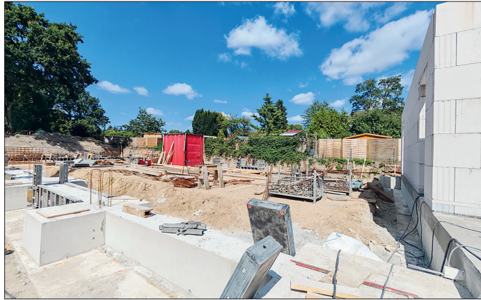
Neben dem Sozialtrakt entsteht an dieser Stelle die Fahrzeughalle mit fünf Stellplätzen.
