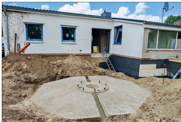
Bei Sanierungsarbeiten wurde die Geschützsetzung am Sereetzer Haus freigelegt.
