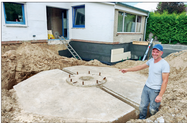
Ralf Werner zeigt seinen historischen Fund, den er bei Baggerarbeiten im Garten seines neu erworbenen Hauses in Sereetz freigelegt hat.
