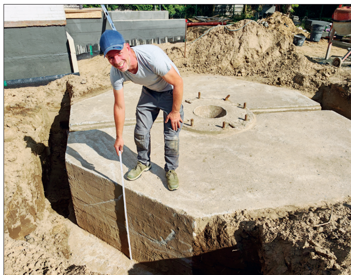
Das Fundament misst einen Durchmesser von vier Metern und ist einen Meter dick.
